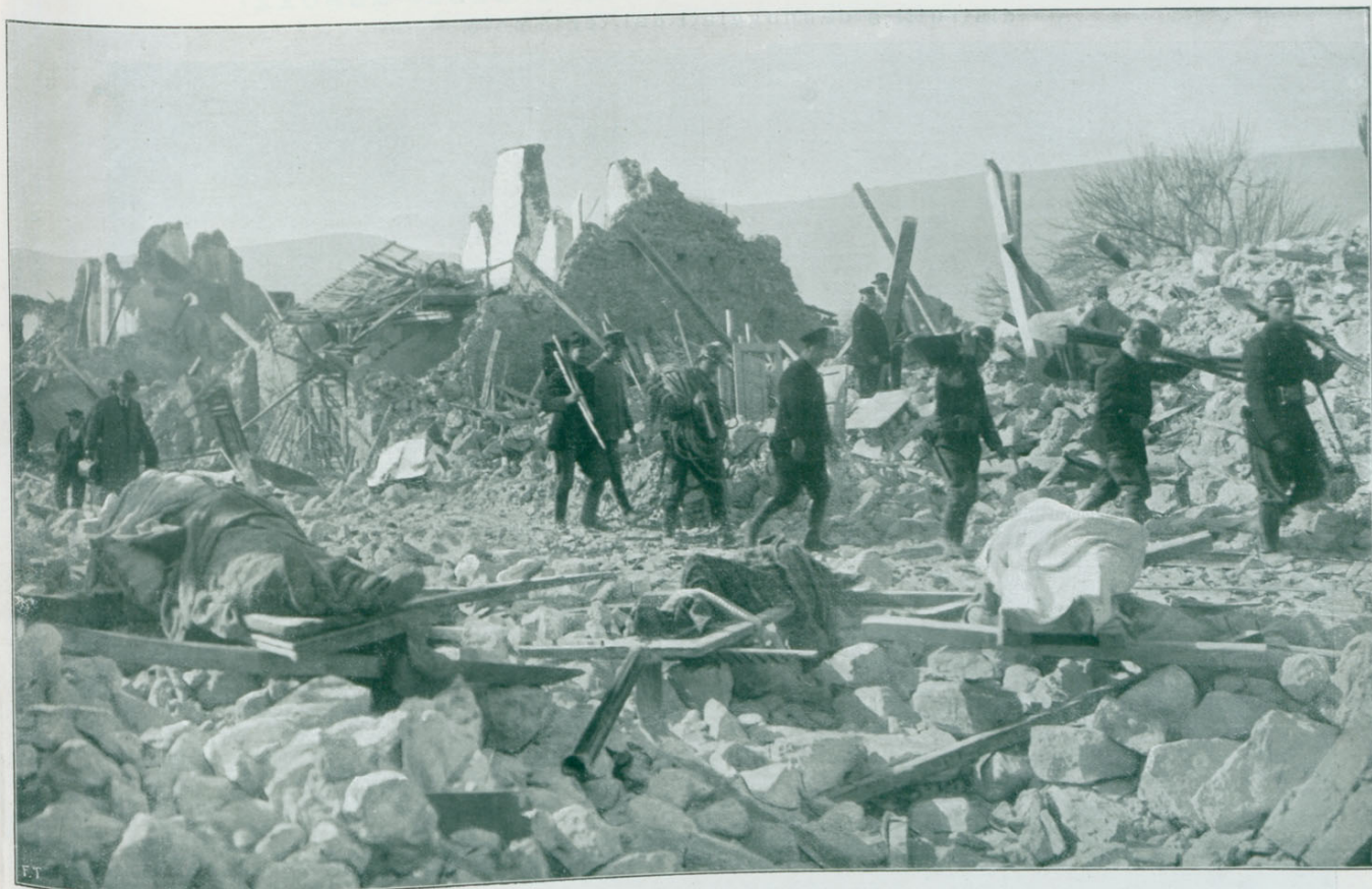
Le prime squadre di salvataggio al lavoro.
