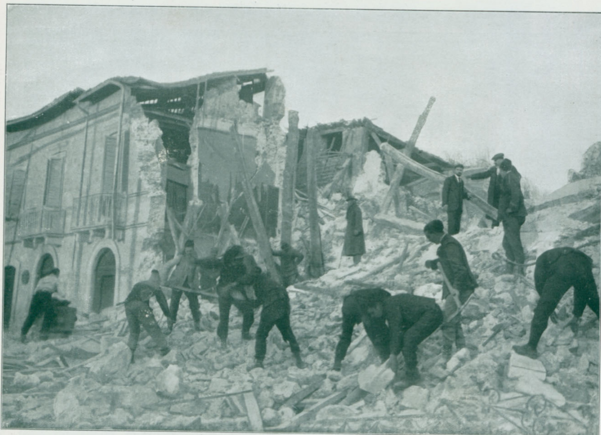
Primi lavori di scavo ad Avezzano.
