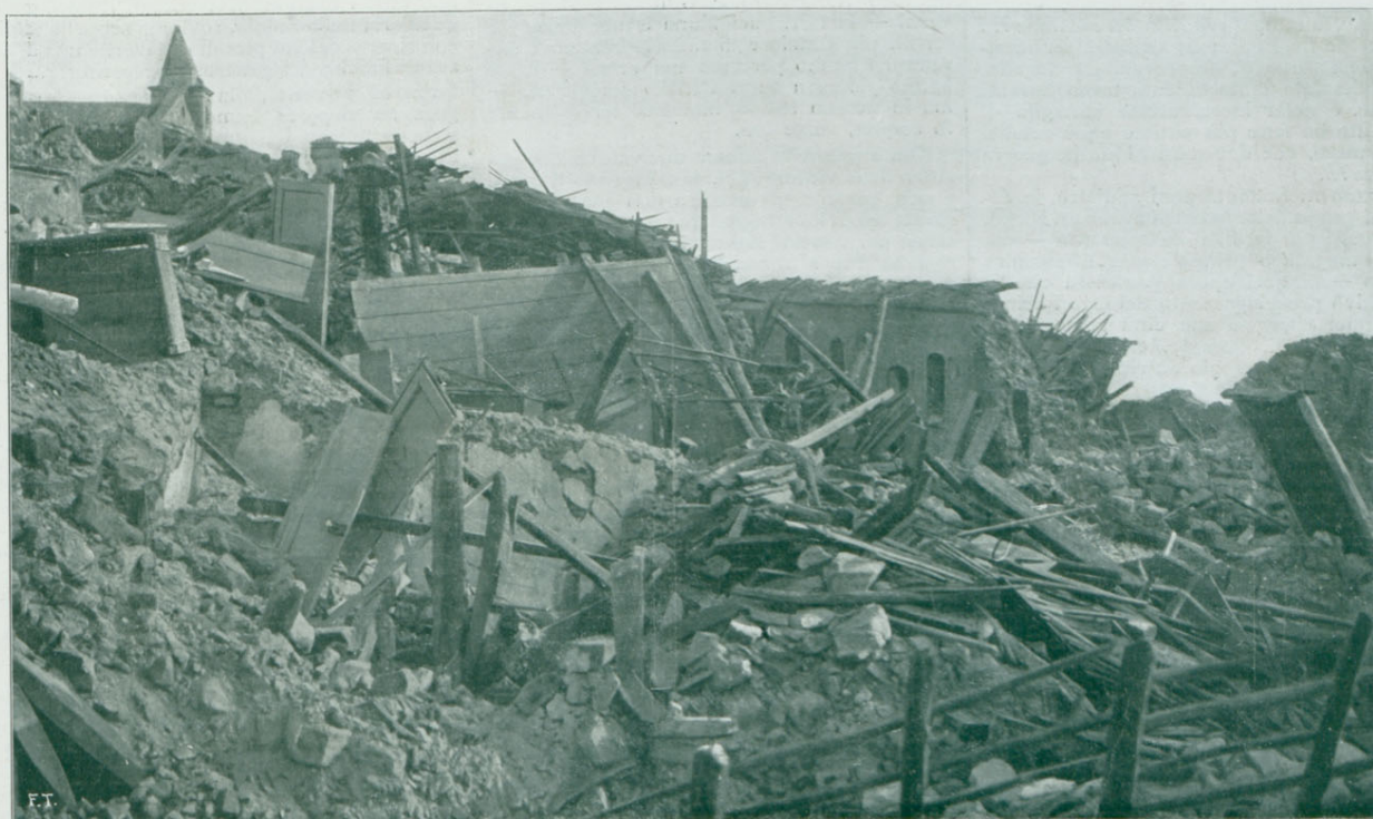
Le rovine sulla strada provinciale di Celano.
